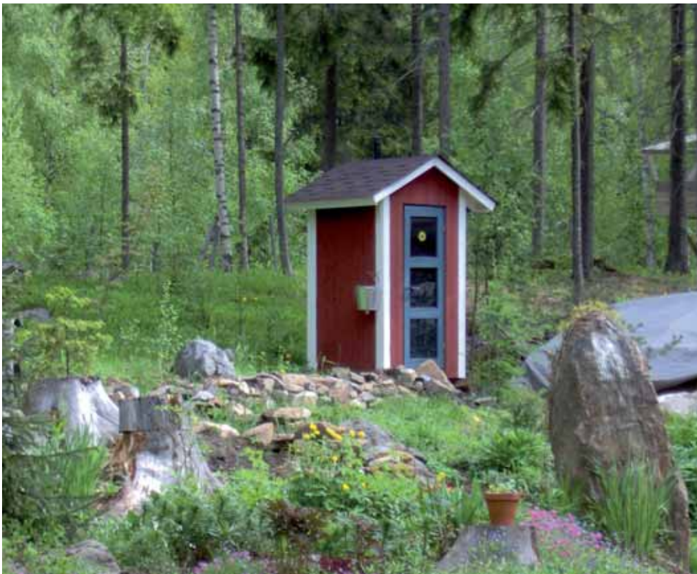
Casa de banho exterior com saneamento a seco.
