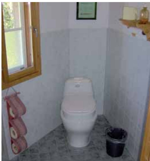
Casa de banho interior com modelo de saneamento a seco unitário.
