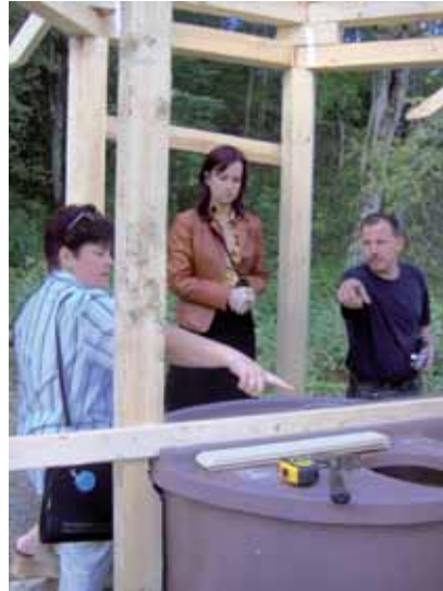
Construção de casa de banho com um modelo de saneamento a seco rotativo de manutenção pelo exterior.
