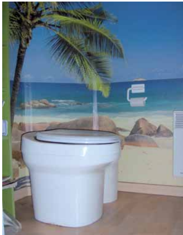
Casa de banho interior com saneamento a seco separado por desnível.
