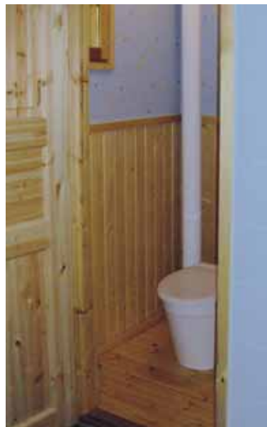
Casa de banho interior com saneamento a seco separado por desnível.
