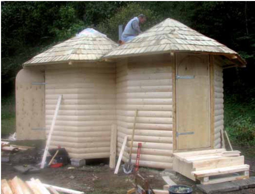
Casa de banho pública com saneamento a seco.
