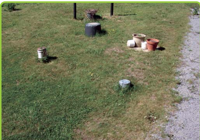
Virtsasäiliöt sijaitsevat puutarhassa maan alla, ja niihin on esteetön pääsy.
