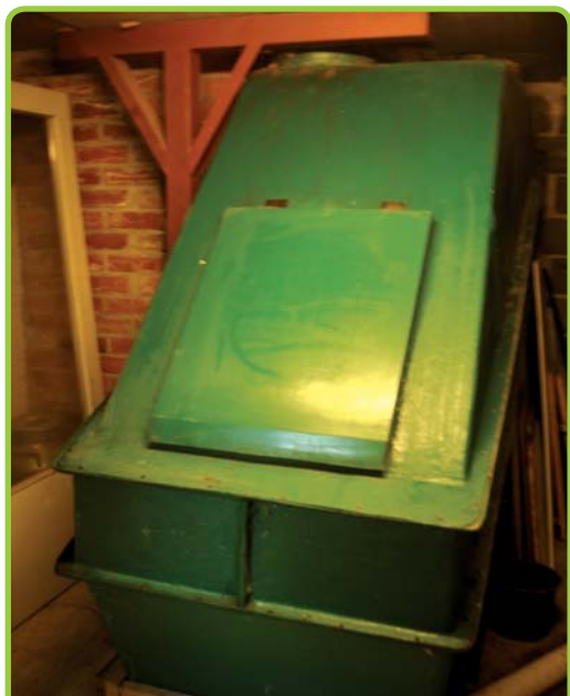
Keittiöjätteet laitetaan samaan säiliöön käymäläjätteiden kanssa.
