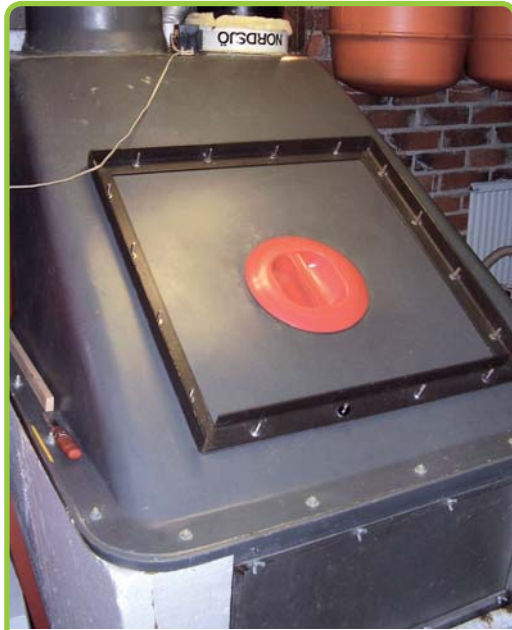
Käymälän säiliö. Käymälä tyhjen- netään säiliön päälle tehdystä luu- kusta.
