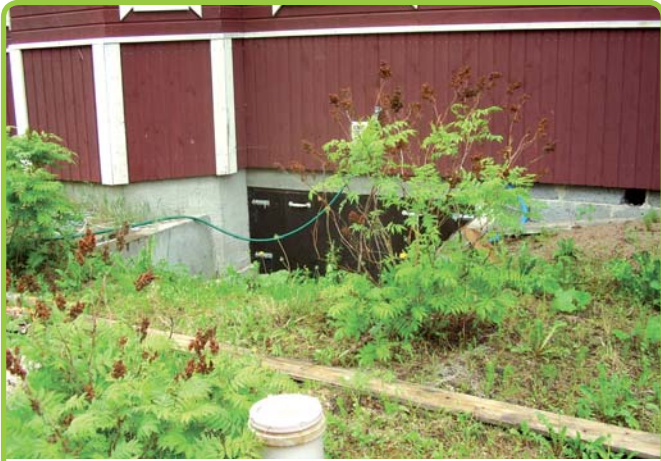
Käymälät tyhjenetään rakennuksien ulkoseinään tehdyistä luukuista.
