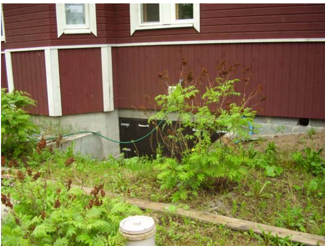
Kuva 2 Käymälät tyhjennetään rakennuksien ulkoseinään tehdyistä luukuista
