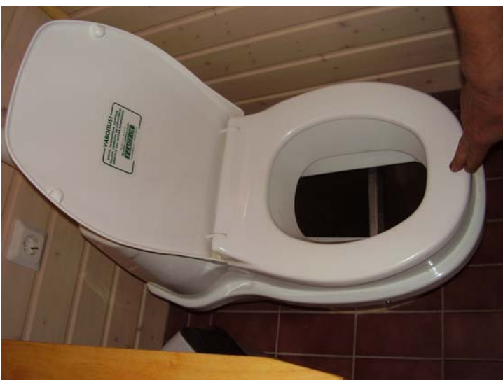
Kuva 4 Käymälässä asioidessa pitää aina istua jotta säiliöön johtava kuilu avautuu
