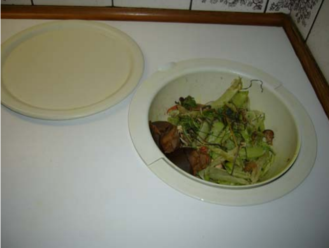
Kuva 4 Keittiöjätteet laitetaan samaan säiliöön käymäläjätteiden kanssa
