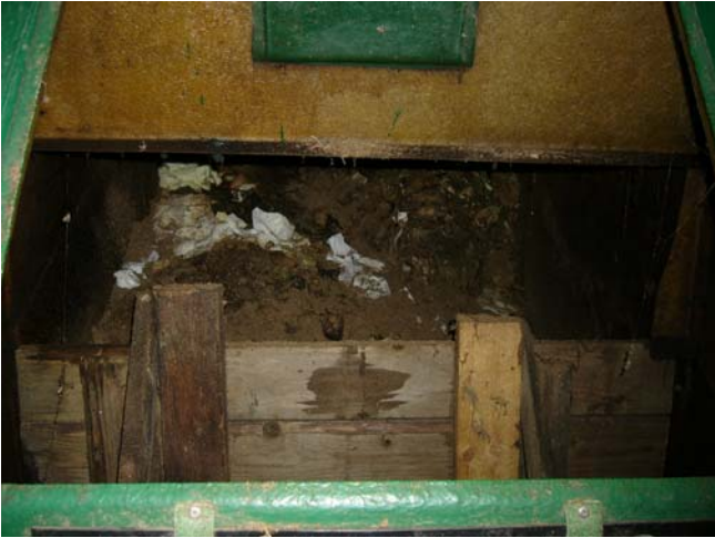
Kuva 6 Käymäläjätösäiliön etureuna eristetty laudoilla
