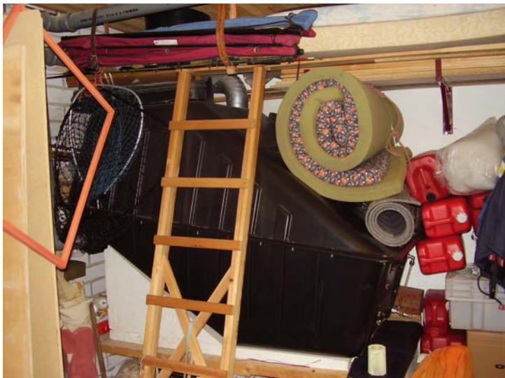
Kuva 4 Säiliö on sijoitettu lämmitettyyn kellaritilaan. Tavarat säiliön läheisyydessä ovat todisteena hajuttomuudesta.
