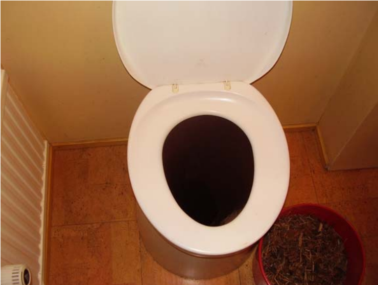
Kuva 2 Käymälätilan kaakelointia pohdittiin mutta sitä ei koettu tarpeelliseksi. Istuimesta johtaa kuilu suoraan alapuolella sijaitsevaan säiliöön.
