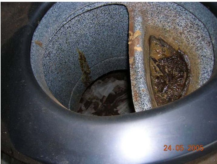
Kuva 8 yllä Virtsan erotteleva käymälä on tukkeutunut
