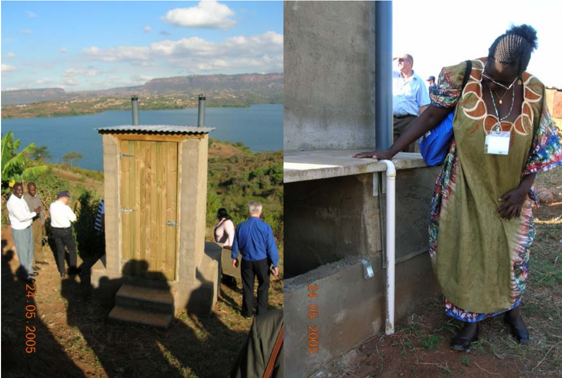
Kuva 6 ja 7 Rakennetut kuivakäymälät edestä ja takaa
