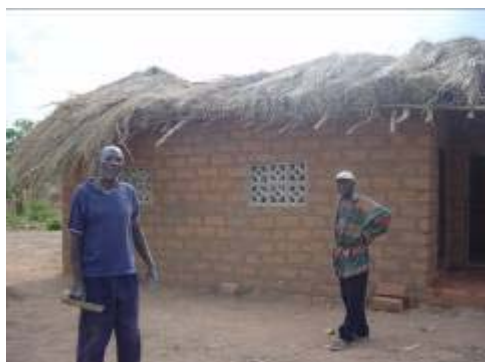
Koulun rakennusmiehiä Mr. Changala ja Mr. X Takana uusi koulurakennus
